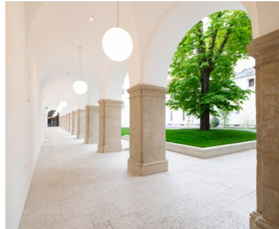
Der einst vermauerte Arkadengang des 1630 errichteten Gebäudeensembles ist wieder geöffnet.
